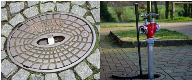
Klassischer Unterflurhydrant und Standrohr.
